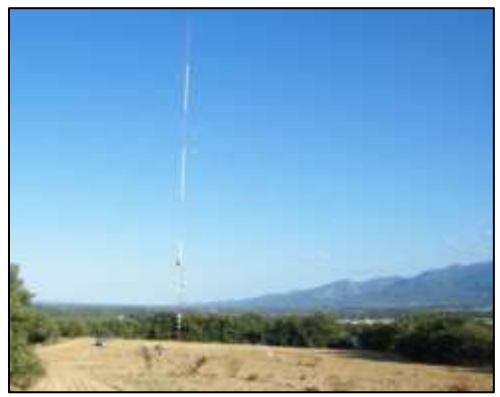
Installation mât de mesure
